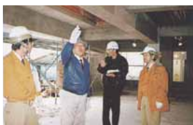
短大の学生寮建築現場
